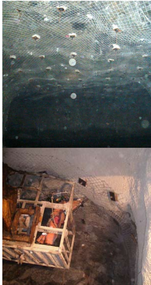
Om de mijnwerkers te beschermen voor steenval worden de wanden van de tunnels in ondergrondse mijnen waarlangs de ertsen worden aangevoerd, uitgerust met gaas.
