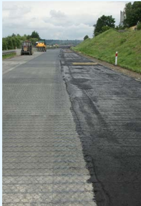
Aanbrengen van Mesh Track voor renovatie van het wegtraject rond Tarnów, aangelegd in 1997.
